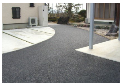
アスファルト
