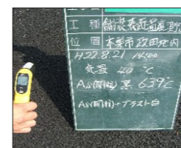
アスファルト舗装
