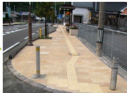
リフレッシュ施工後
