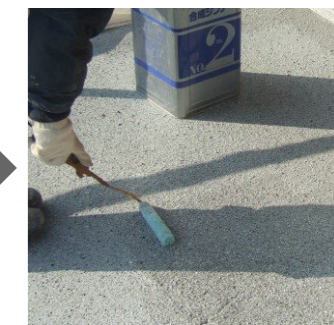
トップコート塗布 表面保護材を塗布し約半日養生をして完成です
