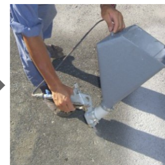
ベースカラー散布 攪拌した材料を塗布または散布します
